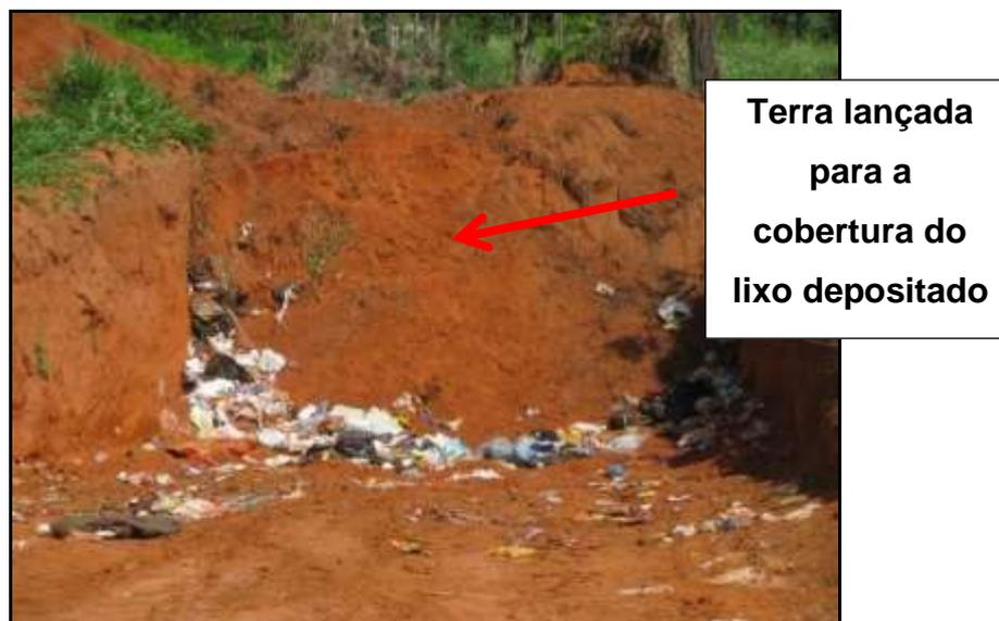
Figura 88 - Terra lançada para cobertura dos resíduos lançados
