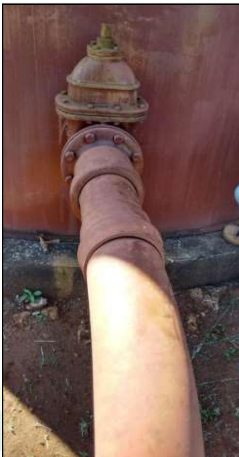
Figura 32 - Reservatório 01 – Detalhe rede de adução
