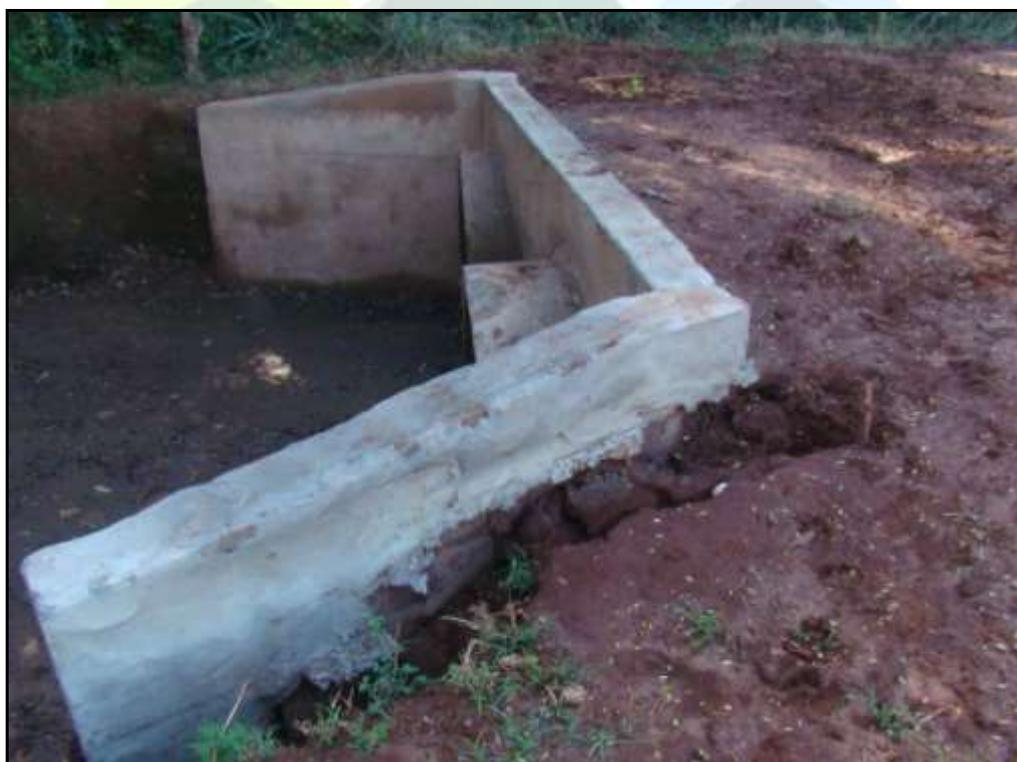
Figura 69 - Detalhe da dissipação a meia encosta, com tubulação dupla
