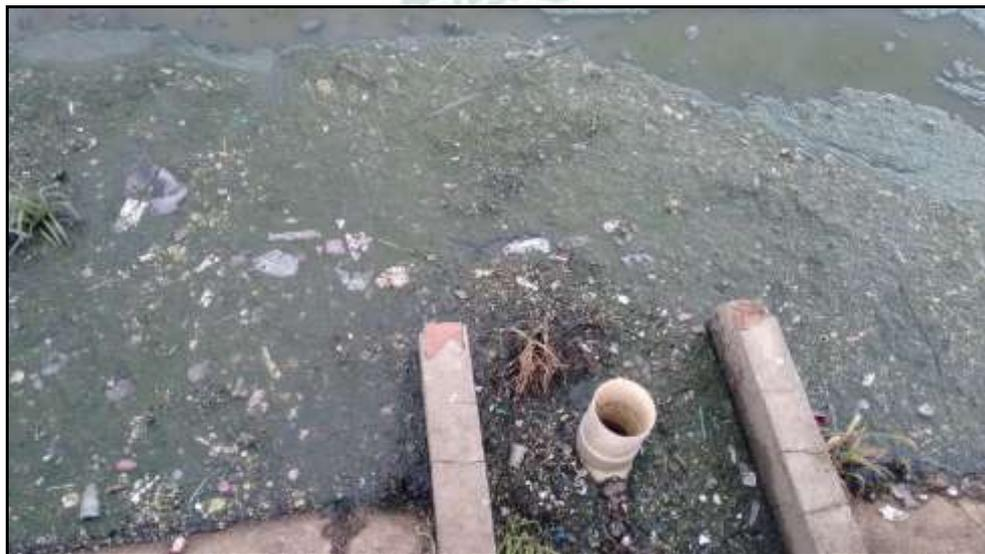
Figura 51 - Lagoa anaeróbia – Falha no sistema de gradeamento
