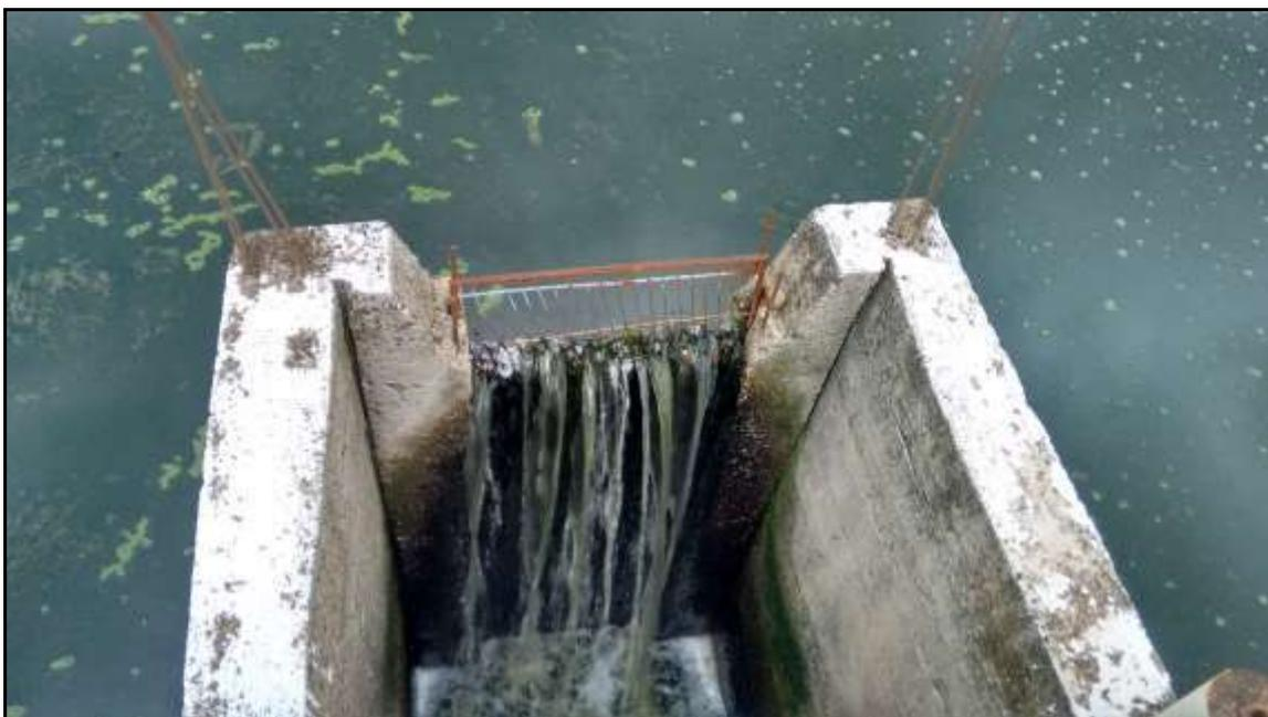
Figura 56 - Sistema de gradeamento final
