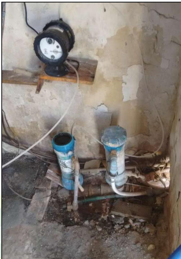
Figura 29 - Sistema de cloração e fluoretação do Reservatório 01
