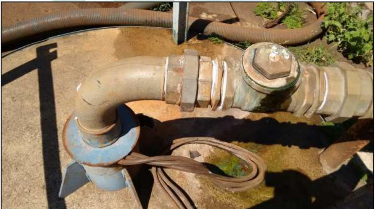
Figura 20 - Detalhe recalque do Poço 01 – Não apresenta hidrômetro, somente válvula de retenção
