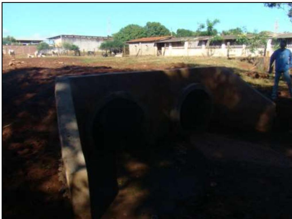
Figura 68 - Dissipação a meia encosta da Bacia 02 com tubulação dupla
