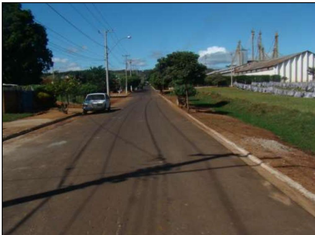
Figura 74 - Rua Firmino Braga – ausência de estruturas de captação
