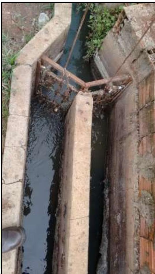
Figura 45 - Detalhe do sistema de gradeamento
