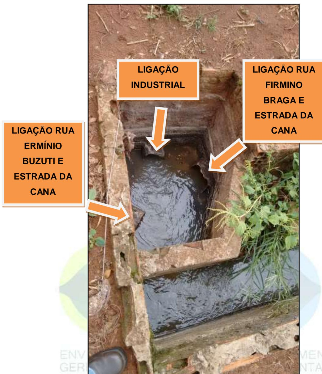
Figura 44 - Detalhe do entroncamento das tubulações no canal de admissão
