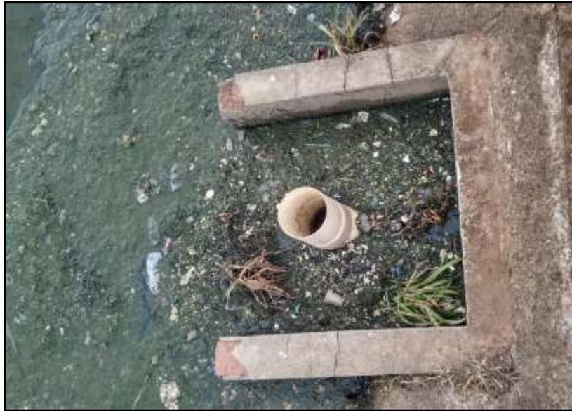
Figura 50 - Lagoa anaeróbia – Falha no sistema de gradeamento
