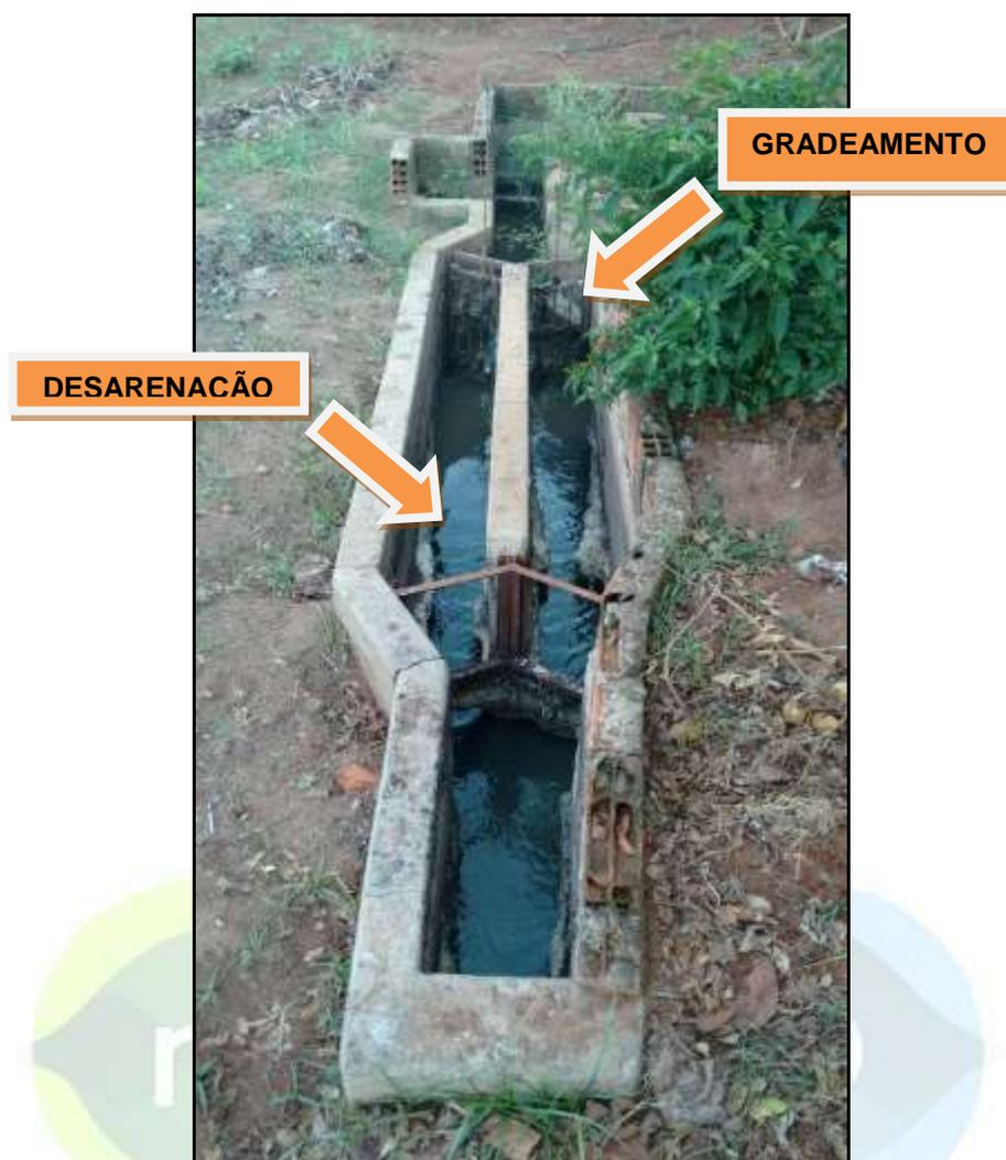
Figura 46 - Sistema de gradeamento e desarenação
