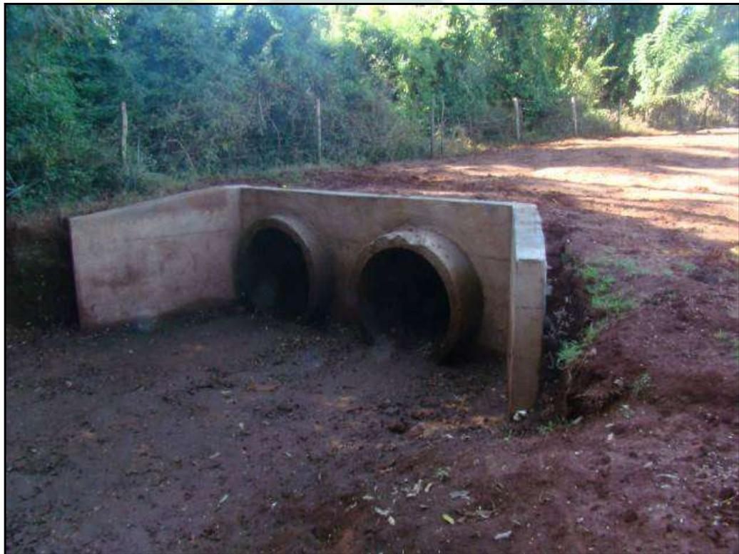
Figura 67 - Detalhe da dissipação a meia encosta, com tubulação dupla
