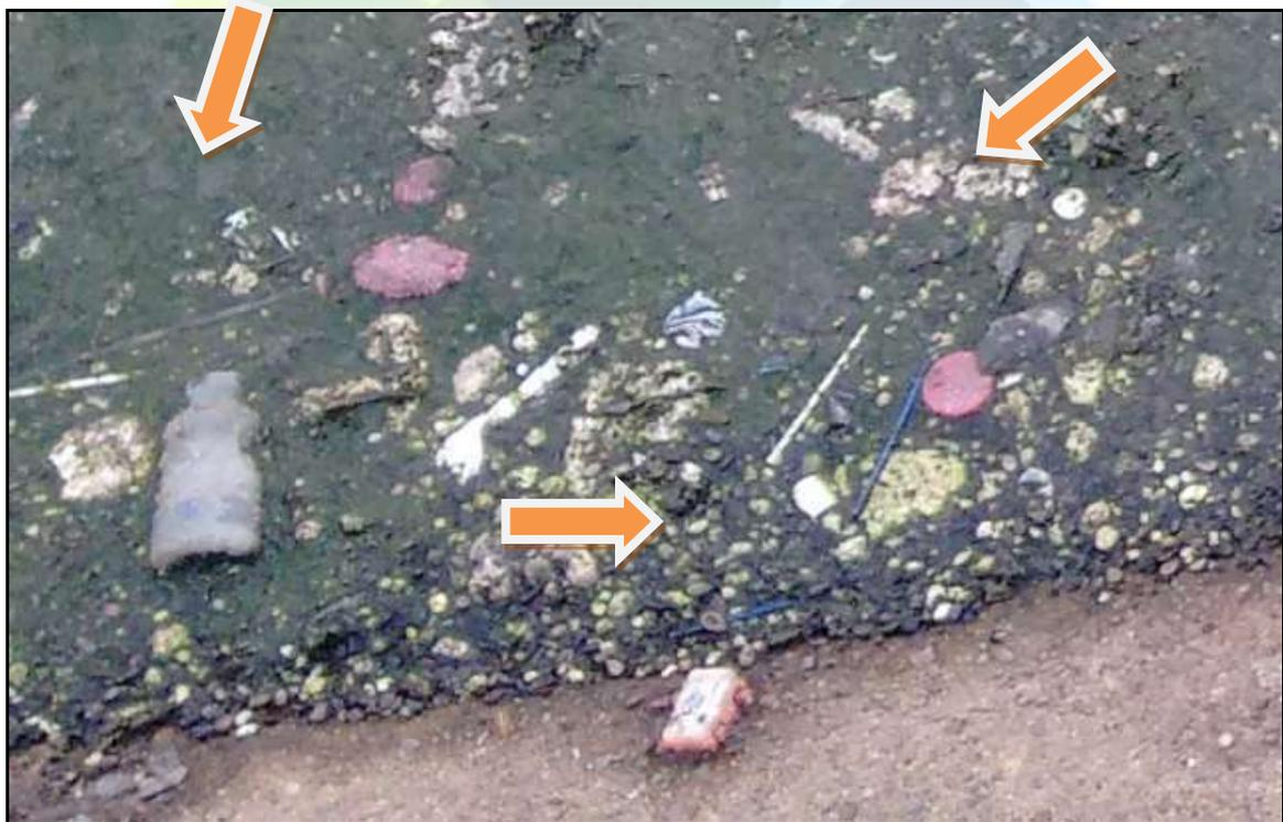
Figura 53 - Lagoa anaeróbia – Detalhe dos materiais encontrados na lagoa anaeróbia
